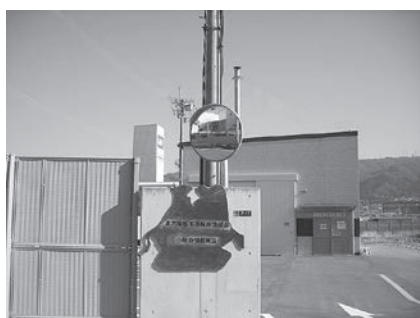
写真-1 小動物焼却施設 正面
