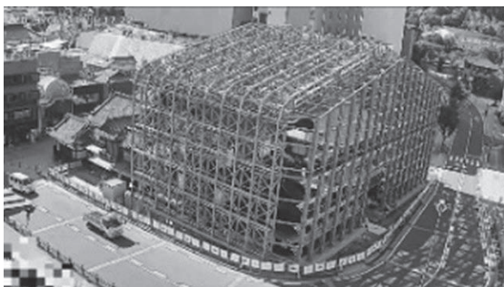
写真-2 前期鉄骨組立工事は妻鉄骨を組み立てて完了
