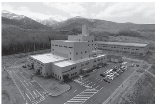
図-1 施設の外観
