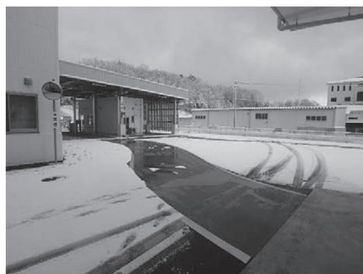
写真-3 邑智クリーンセンターにおけるロードヒーティングの事例
