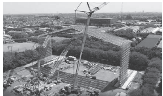
写真-2 メガATMOSのモックアップ状況
