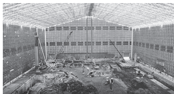
写真-3 解体工事後のATMOSの利用
