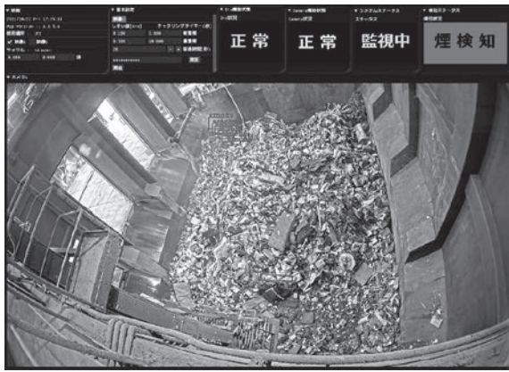
写真-2 ごみピット（上）からの監視状況
