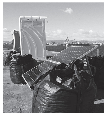
工事現場設置例
