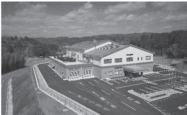
写真-1 施設の全景
