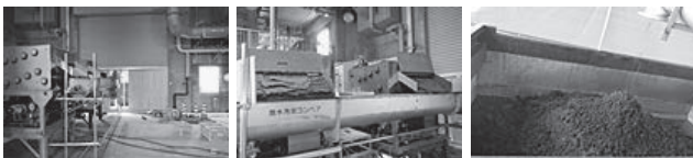
ヘリオス脱水機 レンタル脱水状況
