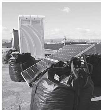
工事現場設置例
