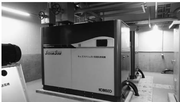
図-4 スクリュー式小型蒸気式発電機 (株式会社 神戸製鋼所)
