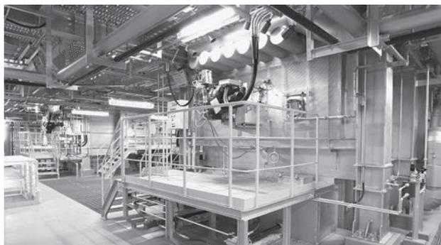
図-4 堅牢なストーカ式焼却炉
