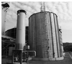
写真-7 ガスホルダ及び余剰ガス燃焼装置
