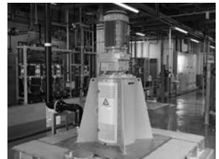
写真-9 高効率曝気攪拌装置
