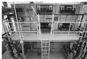
写真-10 生物・薬液脱臭塔及び活性炭吸着塔
