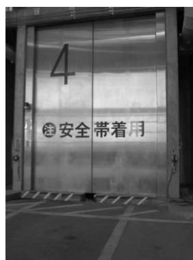
写真12 投入口（安全帯着用表示）
