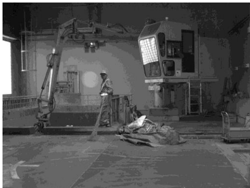
写真1 不燃ごみ投入ホッパー
