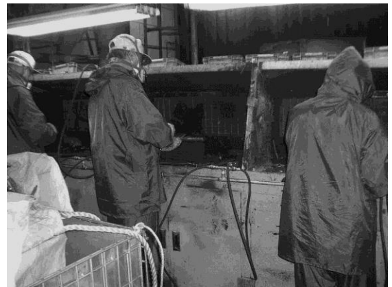
写真 29 トナーカートリッジ分解作業
