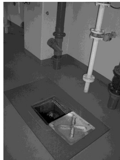
写真14 改造後のマンホール
