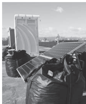
工事現場設置例
