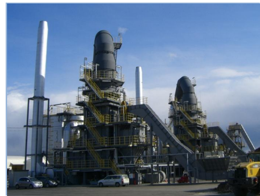
仮設焼却炉(平成25年2月、相馬市)
