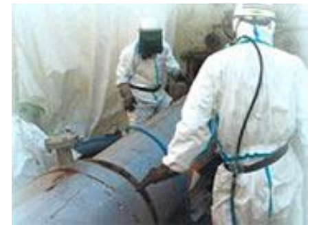
焼却炉の解体の様子
